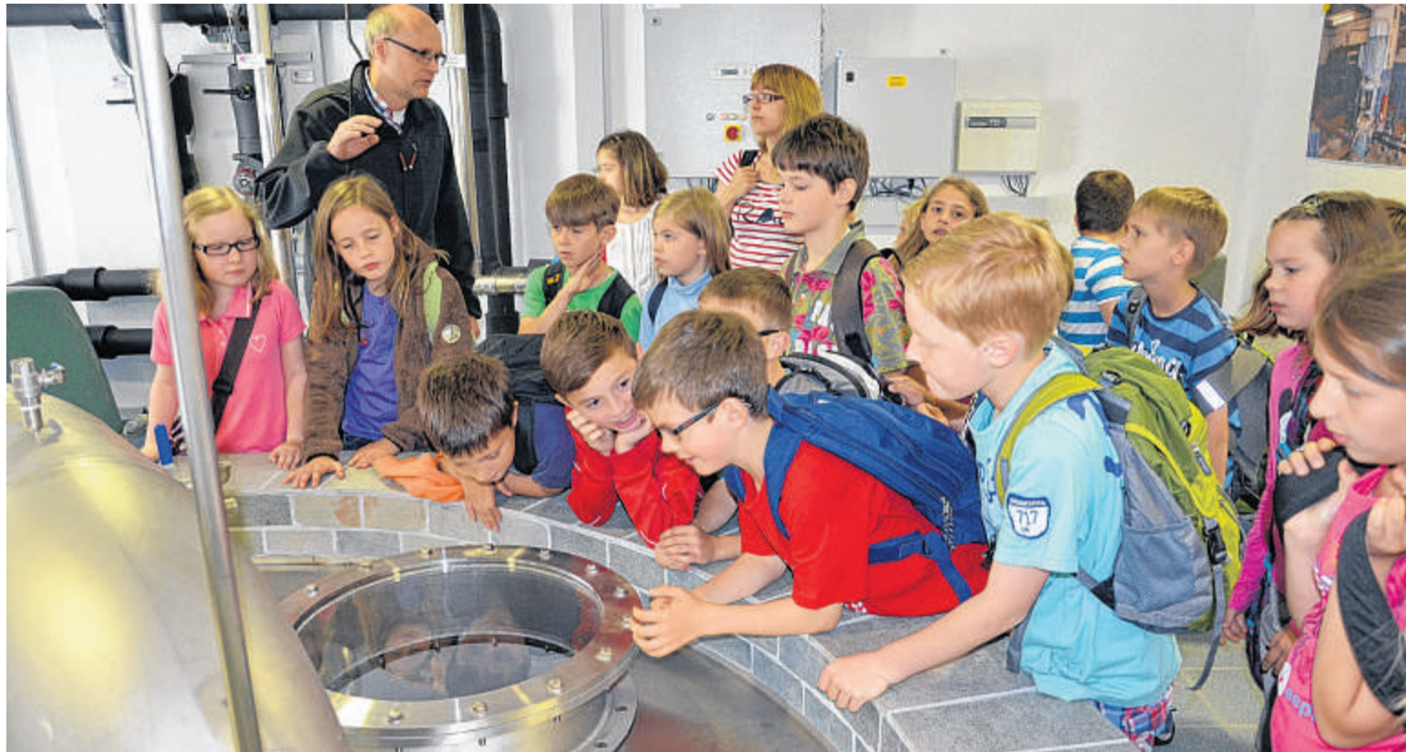
„Boahhh ist das tief!“ - Die Jungen und Mädchen aus der 3c der Sunderner Johannes-Grundschule konnten gestern Morgen einen Blick in den Tiefbrunnen des Wasserwerks in der Röhre werfen. Erläuterungen gab es vom Leiter der Stadtwerke, Jürgen Schwarberg. FOTO: MATTHIAS SCHÄFER
